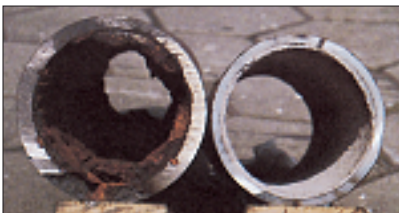
Abwasserrohr vor und nach der Reinigung und Sanierung durch Zementauskleidung
